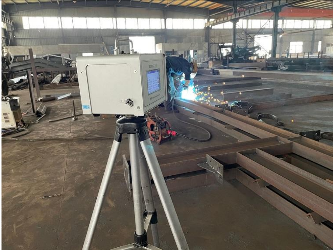
生产车间，次构件焊接岗位
