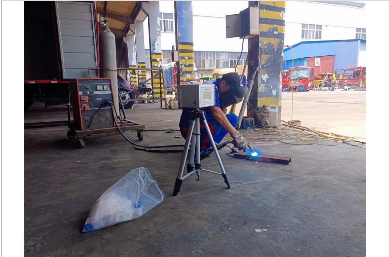
备注：维修车间，焊接岗位
