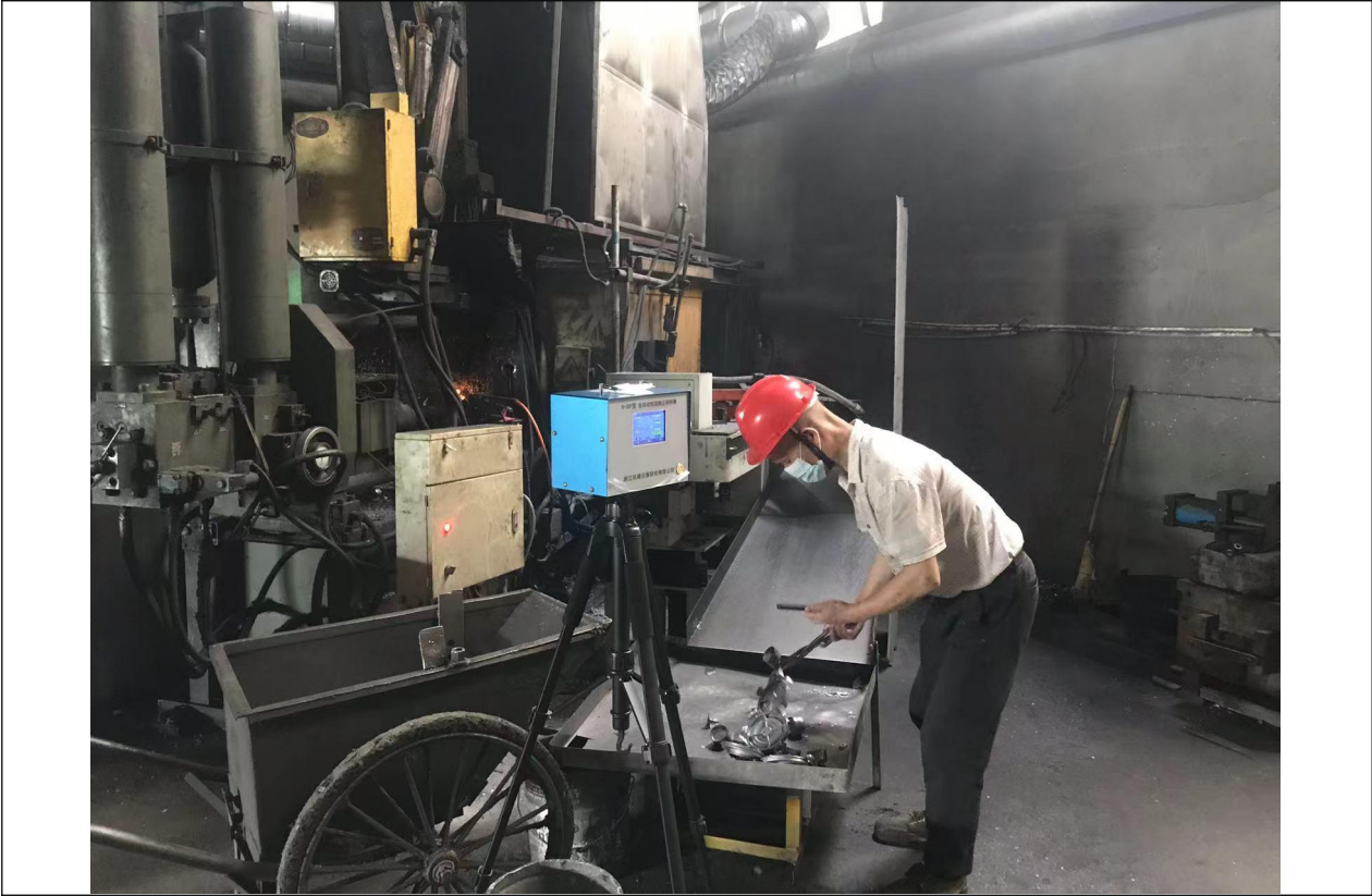
压铸车间、压铸岗位
